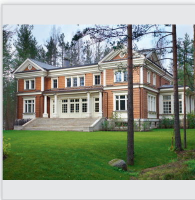
Rezydencja Powierzchnia: 700 m 2 . Ściany wykonane z bali klejonych z 6 elementów grubości 204 mm.
