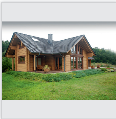
Dom całoroczny Powierzchnia: 220 m 2 (180 m 2 dom + 40 m 2 garaż). Ściany wykonane z bali klejonych z 6 elementów grubości 182 mm.
